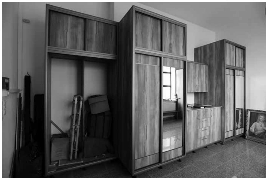
PRACE PRZY NOWYCH MEBLACH W ZAKRYSTII
